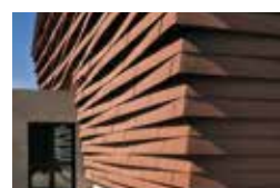
Fitness Center, Sesto Fiorentino, I Studio architetto Fabio Capanni, Florence Idroflorence S.r.l., Badia a Settimo Scandicci (FL) TECU® Classic
