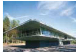
VCNON Traffic control centre, Wolfheze, NL De Architecten Cie, Amsterdam Verkoelen Dakbedekkingen BV, Beegden TECU® Zinn
