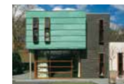
Private Residence, NL Charles Slot Bureau Ruimtelijke Vormgeving, Bergen PBK Technische Installaties BV, Alkmaar TECU® Patina
