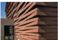
Fitness Center, Sesto Fiorentino, I Studio architetto Fabio Capanni, Florence Idroflorence S.r.l., Badia a Settimo Scandicci (FL) TECU® Classic
