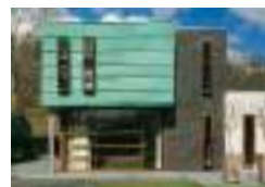
Private Residence, NL Charles Slot Bureau Ruimtelijke Vormgeving, Bergen PBK Technische Installaties BV, Alkmaar TECU® Patina
