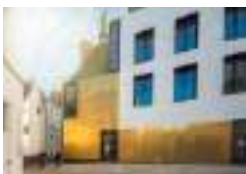
De Patria, Kortrijk, B Adins van Looveren Architects, Gent, B Demeestere Schrijnwerken nv, Moen, B TECU® Brass_bond ©Photo: Lennen Descamps
